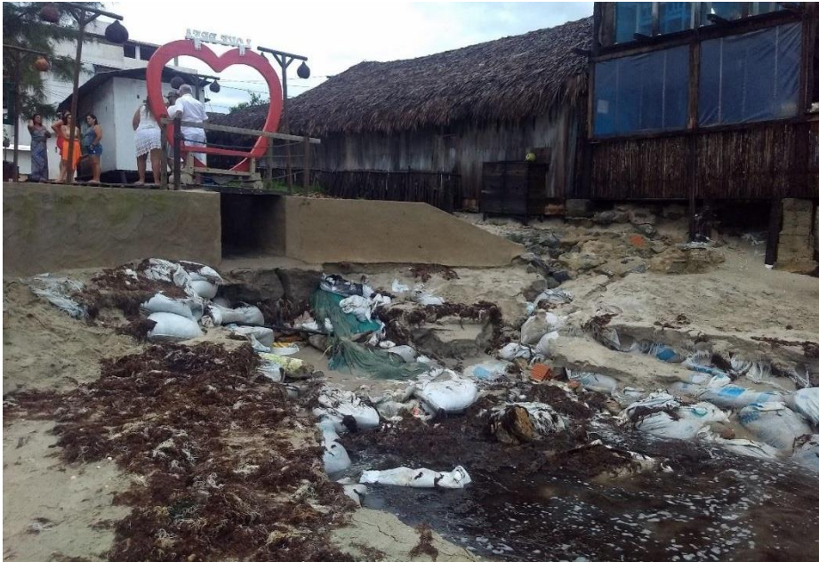
Figura 27: Barracas na faixa de praia, provocando mudanças nos padrões morfodinâmicos e hidrodinâmicos locais.
